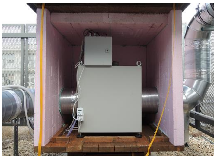
Instalace PET-02 do vzduchotechnické trasy na pracovišti nukleární medicíny
